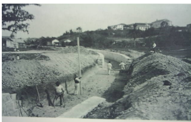
Imagem 10: Trabalhadores efetuando a construção da Avenida Hercílio Luz 363
